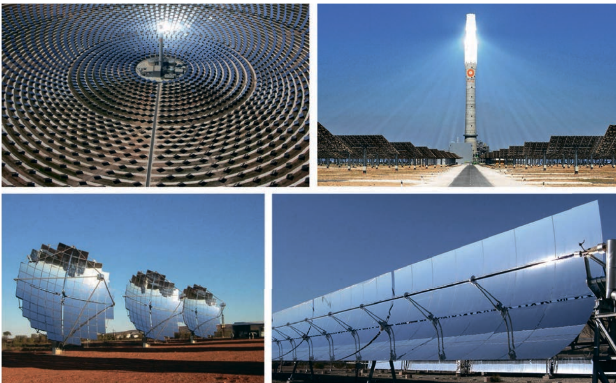
Рис. 4.10. СЕС баштового типу, тарілчасті та з параболічними концентраторами
