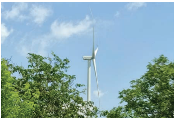
Рис. 4.5. ВЕУ Дністровської вітроелектростанції
