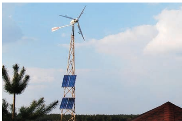
г) Приклад комбінованої вітро-сонячної генеруючої системи
