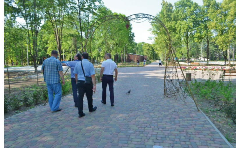
Фото реконструкції центральної алеї міського парку м. Вільногірськ, 18 червня 2018 р.
