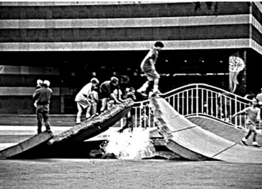
1983, зруйнована набережна в м. Чаттануга
