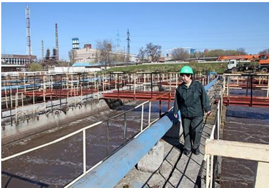
Мал 29. Каналізаційні очисні споруди ПрАТ «Северодонецьке об'єднання «Азот»
